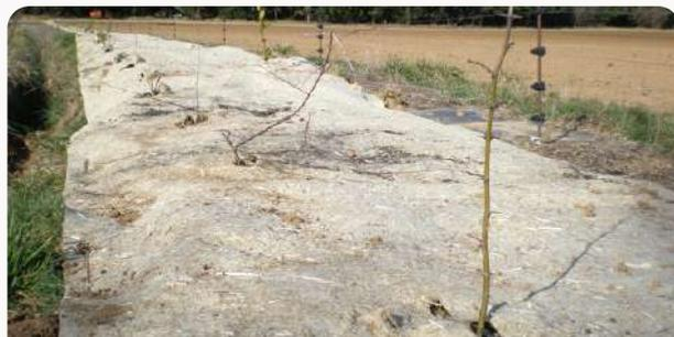
Rouleau de chanvre de 1m20 de large. Des agrafes tiennent le rouleau au sol mais une dérouleuse plastique peut aussi être utilisée pour enterrer correctement les bords du rouleau. A Sillans-la-Cascade (83)
